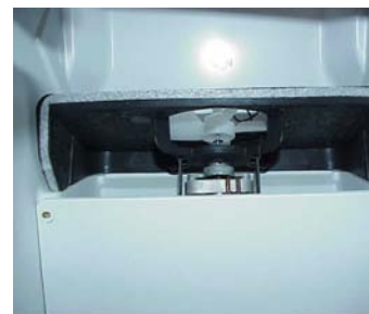
Evaporator Fan Motor Assembly
